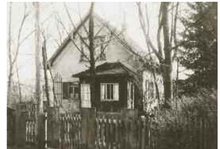
Das Moor-Haus von Norden, 1926
